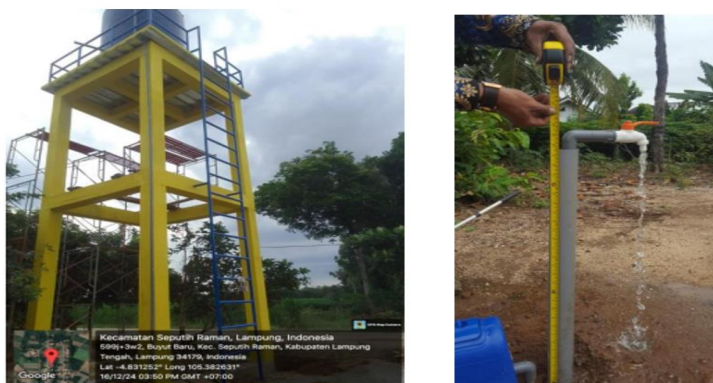
Gambar 5. Pembangunan SPAM dengan Jaringan Perpipaan
